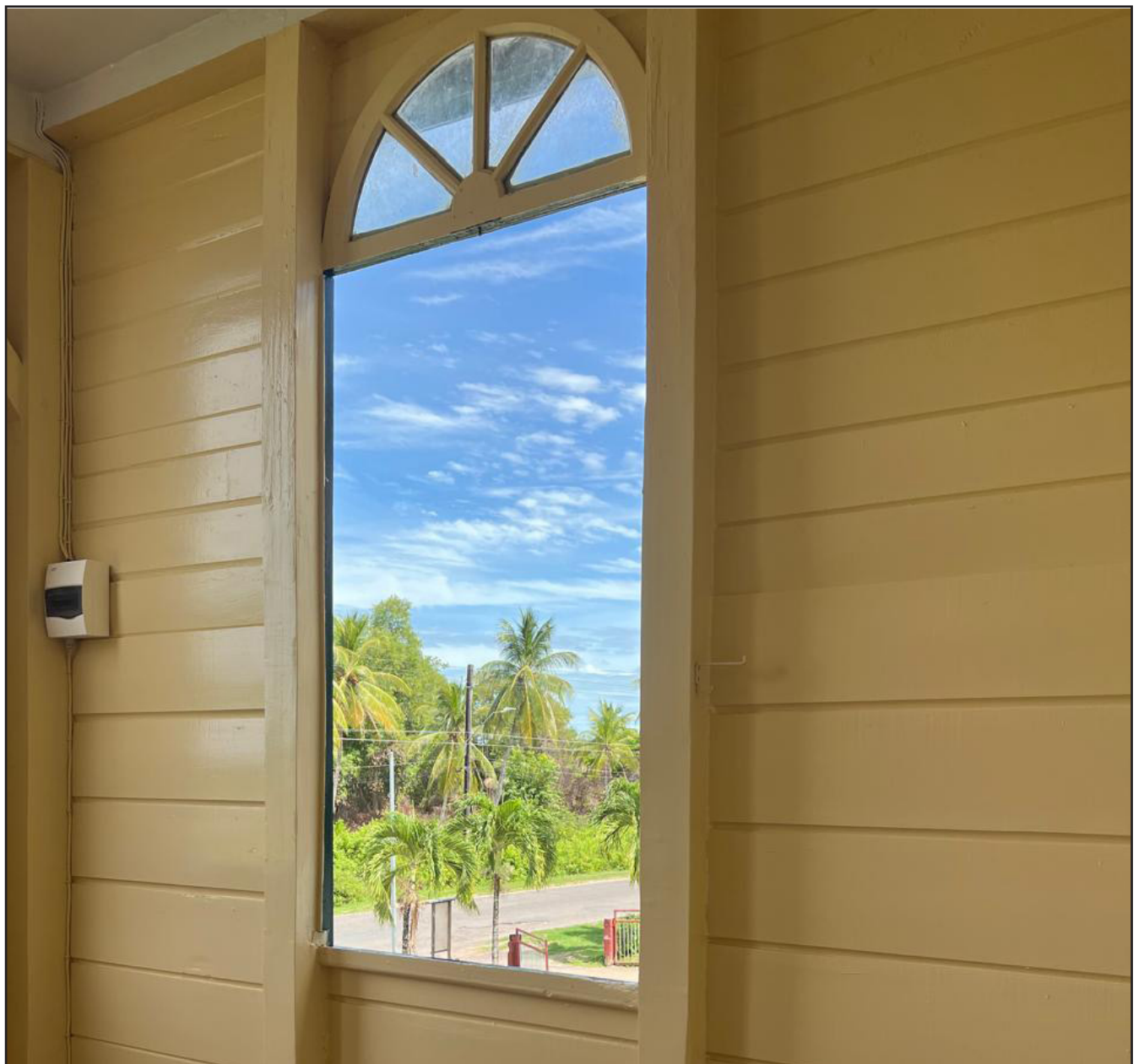
Dit is geen schilderij aan de muur maar een foto uit het open raam van het FCJM klooster te Coronie dat gerenoveerd wordt met een donatie van een fonds van de zusters
